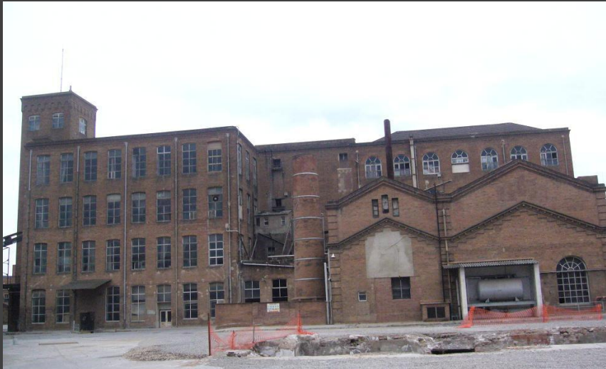
Fabra i Coats, Centro de Interpretación y Sala de calderas
