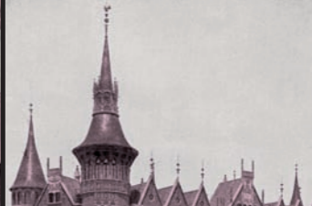
Hospital de la Sta. Creu i St. Pau, L. Domènech i Montaner, 1901
